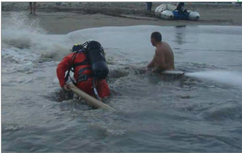
Figura 11: Enterramiento con manguera hidroneumática
