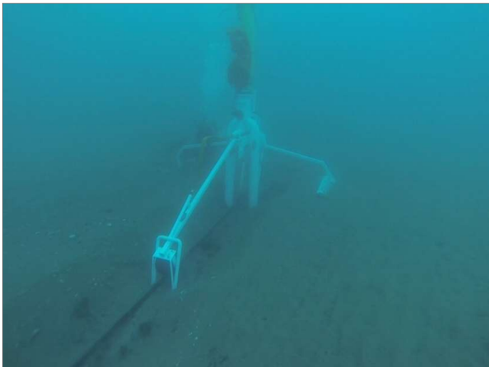
Figura 12: Jet Sled para enterramiento en aguas someras
