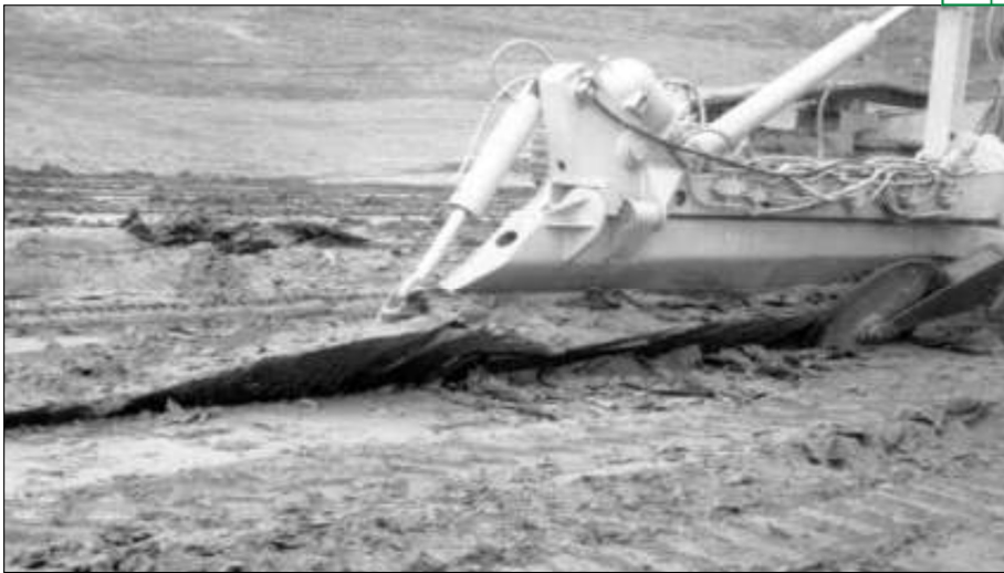
Figura 18: Huella provocada por la excavación con arado
