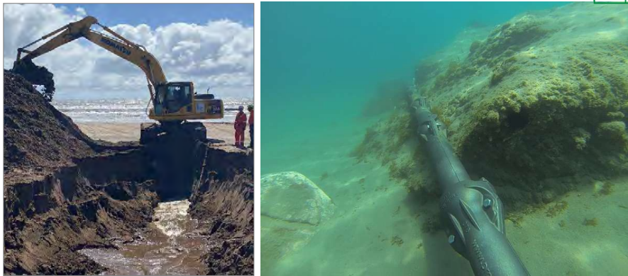
Figura 10: Enterramiento de cable protegido en zanja.
