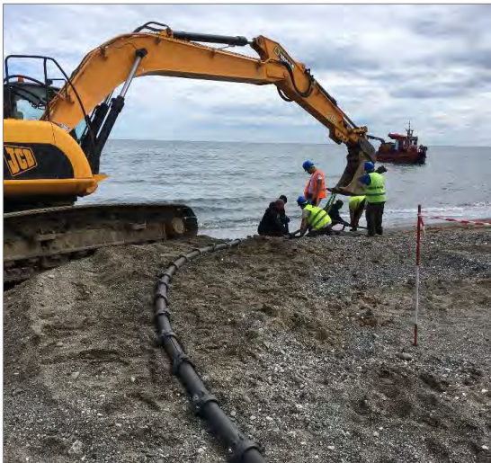
Figura 9: Tubería articulada para protección de cable
